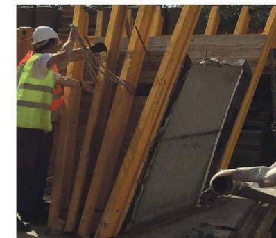
Hybride Lösung einer 3D gedruckten Schalung für den Betonguss
